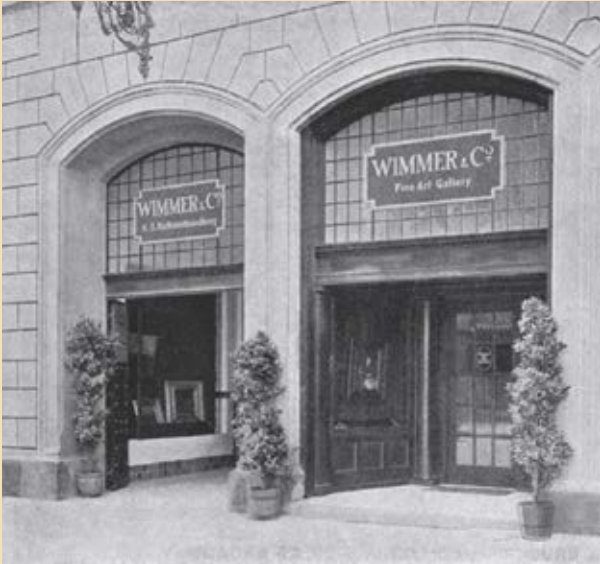
Galeria Wimmer, Monachium, ok. 1907
